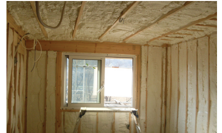
수성연질폼 단열재 시공
